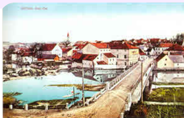
Most mezi Gmündem a Českými Velenicemi v roce 1907. Patrně jsou stožáry trolejového vedení na jeho předpolí.
